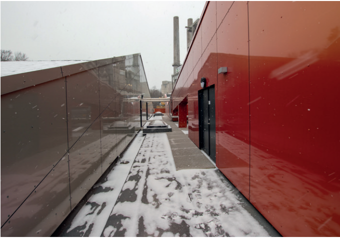
Fasadeplatene er laget slik at det gir forskjellig fargespill i forskjellig lys.
